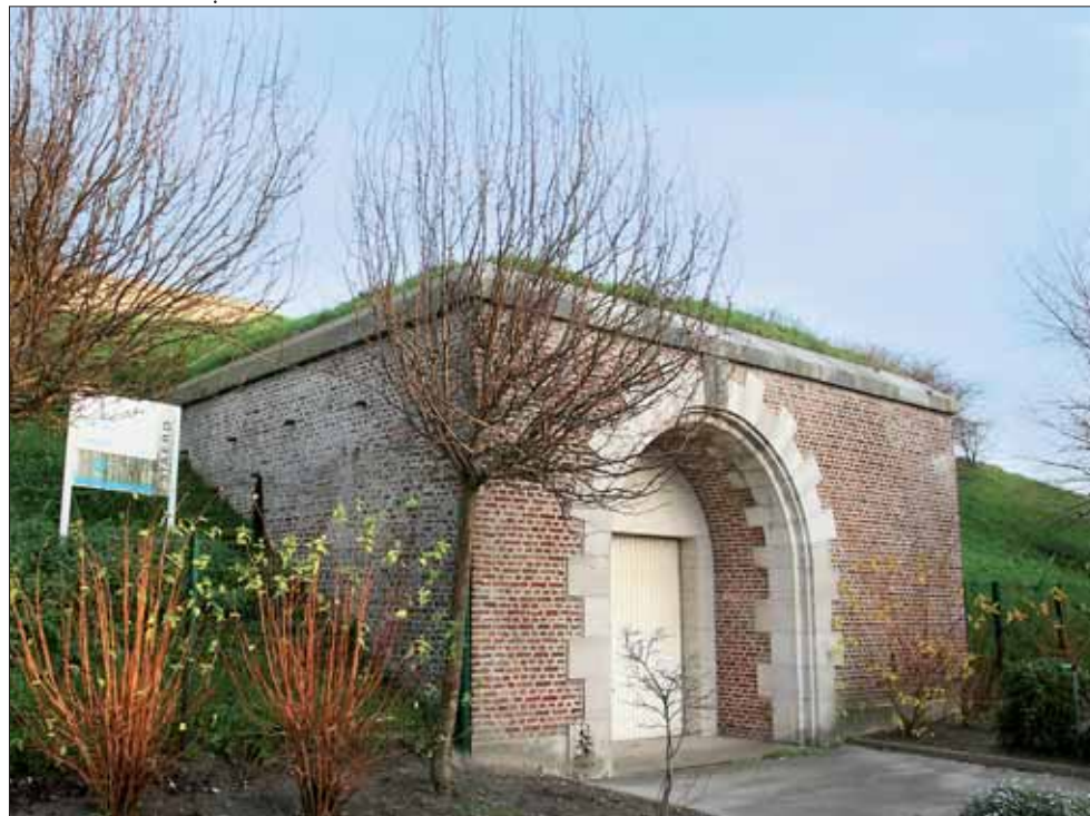
Entrée du réservoir Guillemot.
